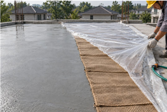
AI构造示意 · 混凝土覆盖保湿养护
