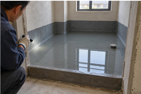
AI构造示意 · 闭水观察
