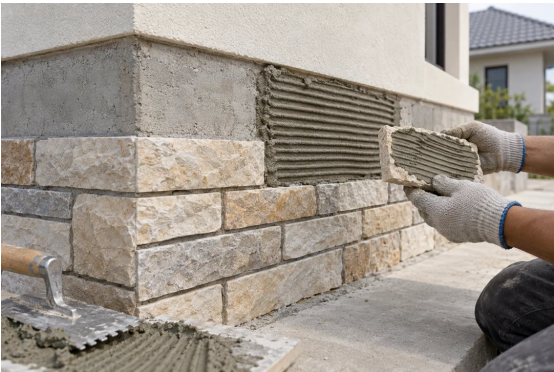
AI构造示意 · 文化石粘贴基层
