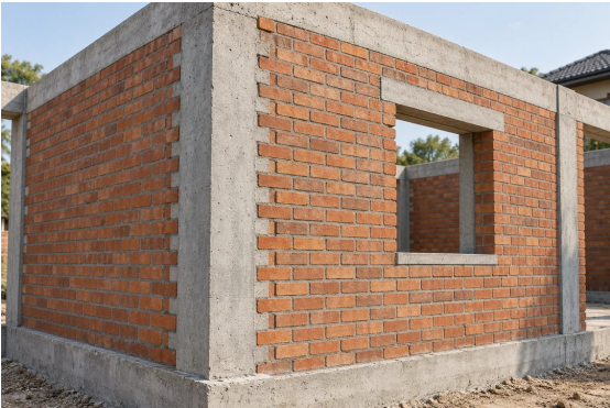
AI构造示意 · 砌体马牙槎与过梁连接
