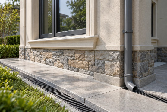
AI构造示意 · 窗套、墙裙与室外散水收尾
