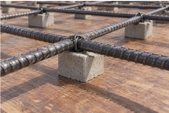
AI构造示意 · 钢筋与保护层垫块
