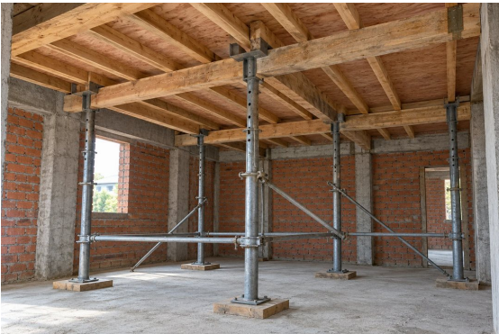
AI构造示意 · 楼板模板与落地支撑
