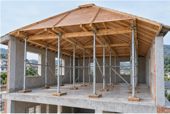
AI构造示意 · 斜屋面模板支撑
