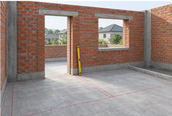
AI构造示意 · 墙体定位线与门窗洞口
