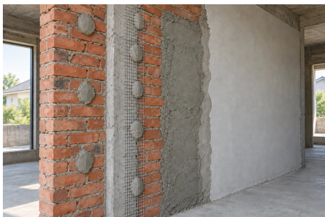
AI构造示意 · 墙体基层与分层抹灰样板
