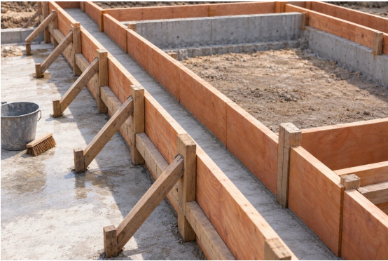
AI构造示意 · 基础模板清理与加固
