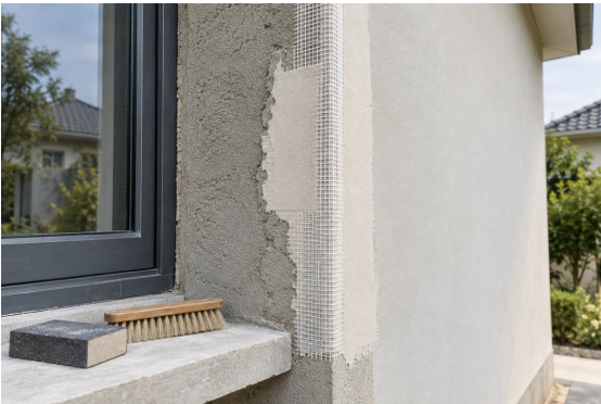
AI构造示意 · 外墙基层与增强网
