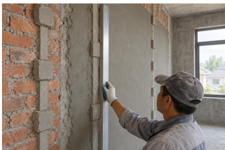
AI构造示意 · 灰饼与冲筋
