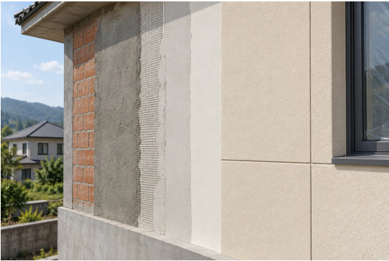
AI构造示意 · 外墙基层与饰面涂层
