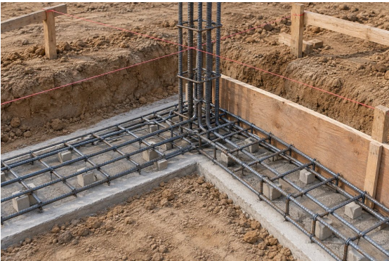
AI构造示意 · 基础轴线与预留钢筋
