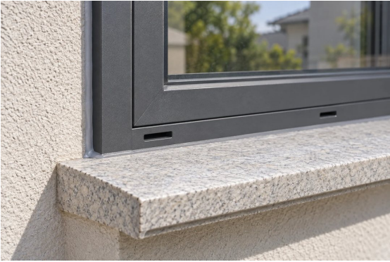
AI构造示意 · 窗框密封与外窗台收口
