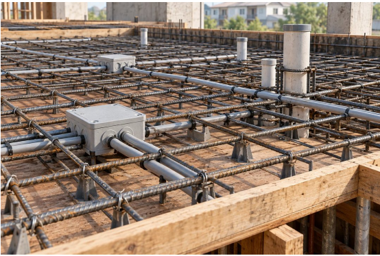
AI构造示意 · 楼板管线与预留套管
