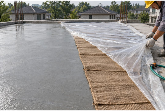
AI构造示意 · 混凝土覆盖保湿养护
