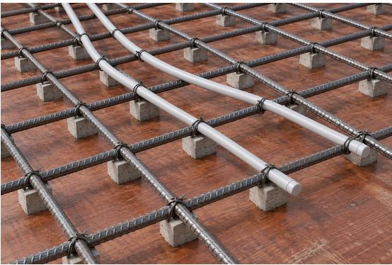
AI构造示意 · 楼板钢筋、模板与预埋协调
