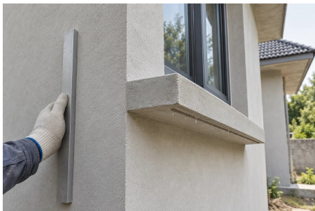
AI构造示意 · 抹灰成面与滴水槽
