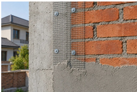
AI构造示意 · 不同材料交接处的增强层
