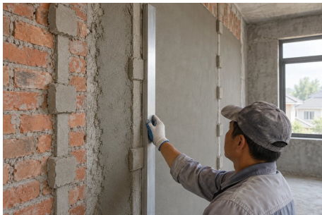
AI构造示意 · 灰饼与冲筋
