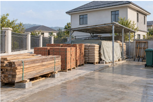
AI构造示意 · 材料分区与防潮覆盖 01 材料、工具分类分区摆放，物料标识清楚。 02 按材料特性防水、防潮，不占用作业及通行空间。 03 明确临时垃圾堆放点，建筑垃圾及时运至指定位置。 04 砖体湿润、混凝土及抹灰养护按对应工序纳入日常管理。
