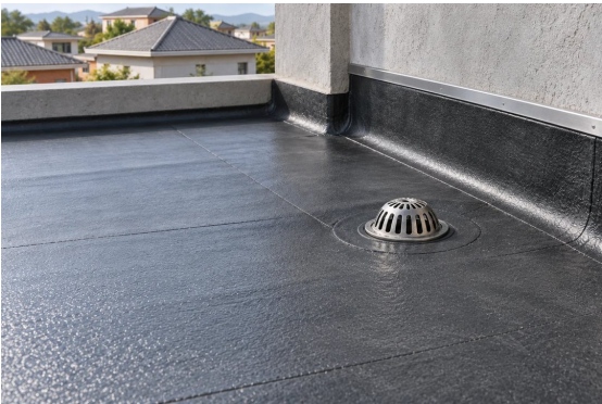
AI构造示意 · 排水口与防水节点收口
